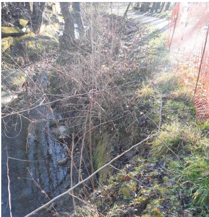
Figura 9 – Erosione spondale in sponda sinistra, vista da valle verso monte
