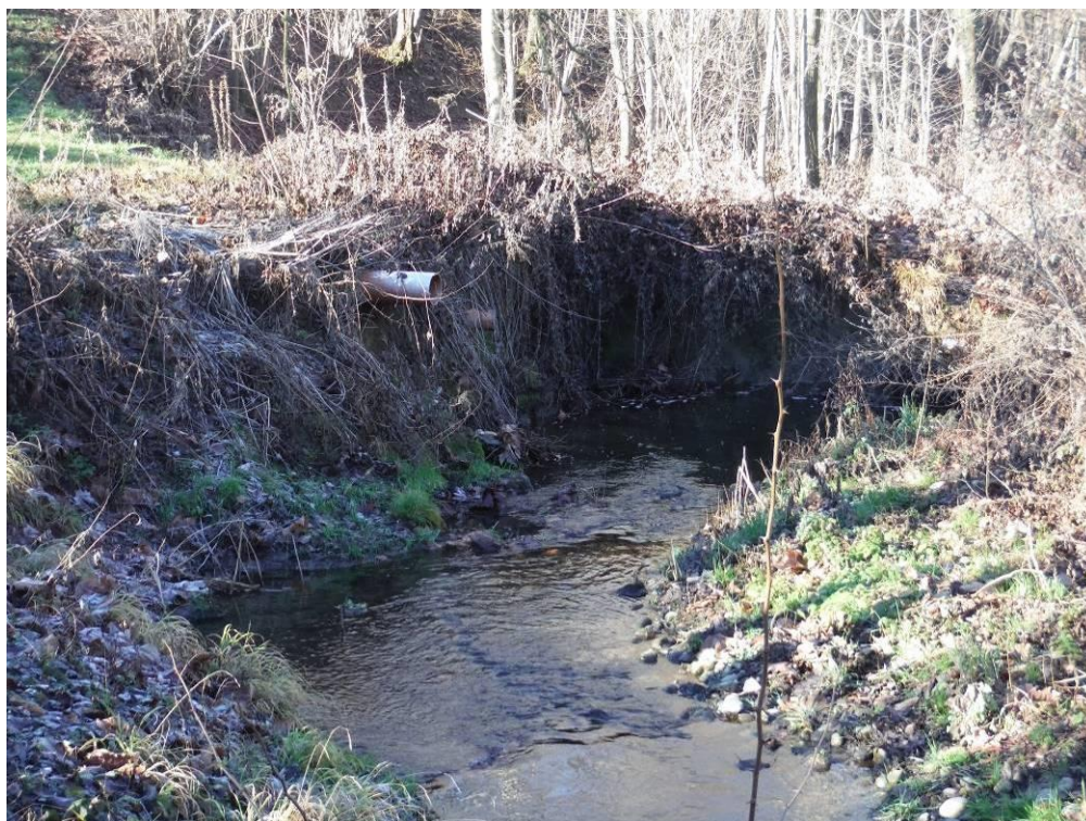
Figura 10 – Erosione spondale in sponda sinistra, vista da monte verso valle
