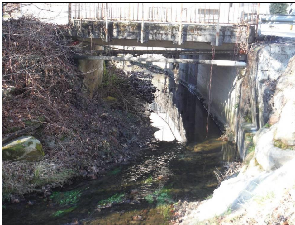
Figura 2 – Accumulo di sedimenti sotto l'attraversamento di via Turati, vista da monte
